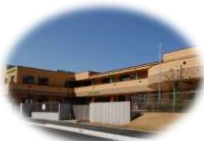
緑が丘はぐみの杜保育園 047-458-7005 (最寄駅) 八千代緑が丘 駅
